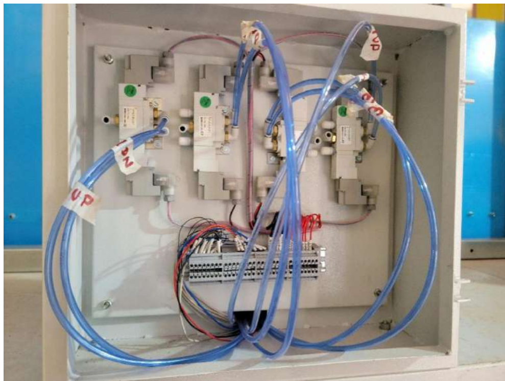
Fig 3. Cylinder control ckt
